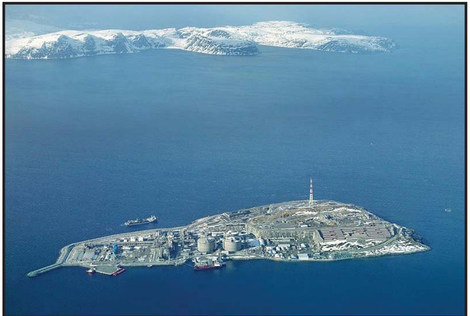
Hammerfest LNG Plant Melkøya
